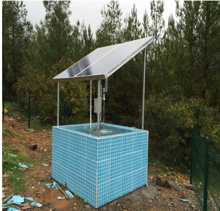
Şekil 9. Sistemde kullanılan su havuzu ve üzerine kurulu güneş panelleri.
