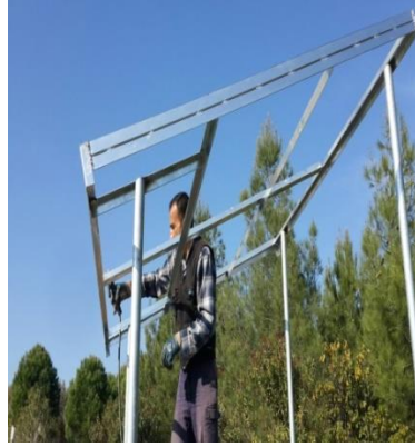
Şekil 5. Güneş panellerinin havuzun üzerine sabitlenmesi için kullanılan galvanizli L profiller ve silindirik borular.
