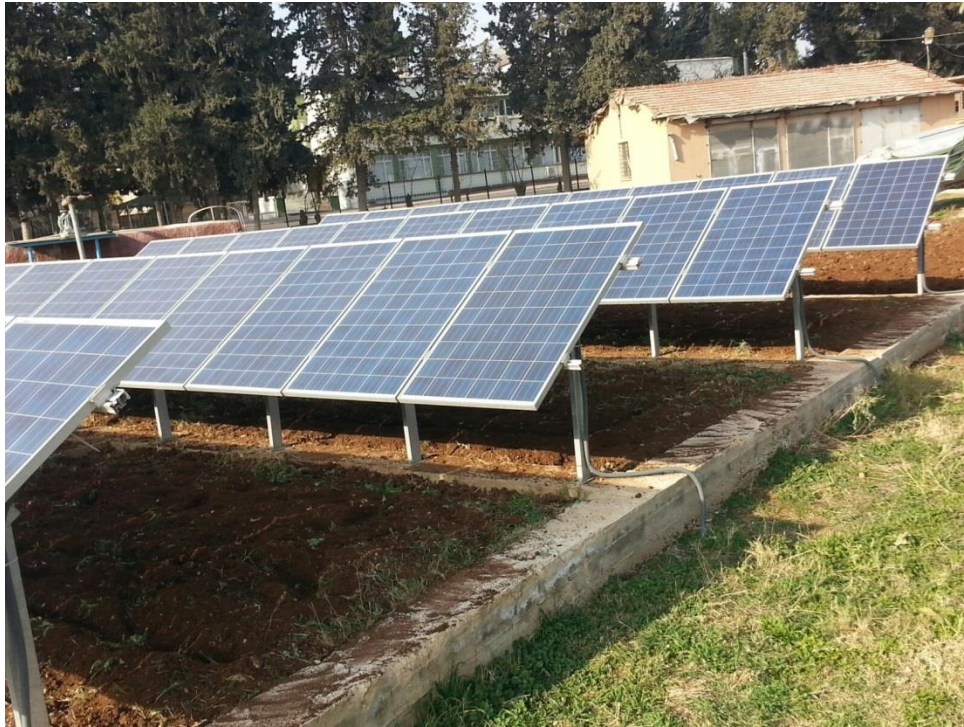
Şekil 5: 10 KWp gücündeki GES’den bir kesit.
